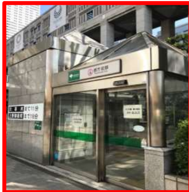
地下鉄出入口 (都庁前駅 A4)
