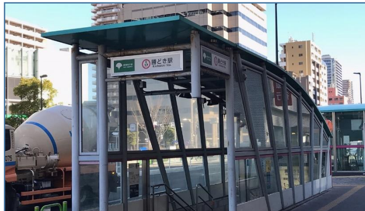
地下鉄出入口
