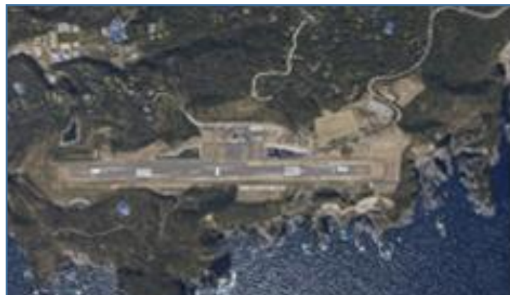
土地 (神津島空港用地)
