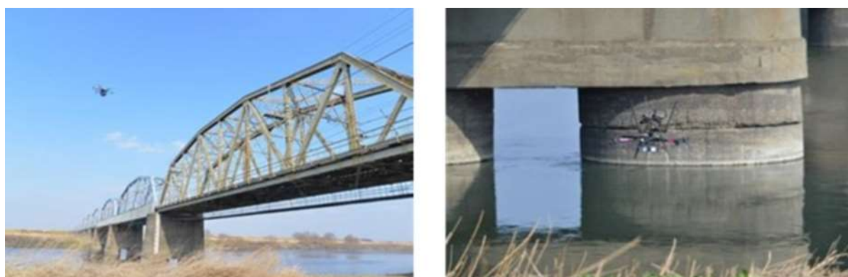
写真 2 ドローンによる施設点検のイメージ 6
