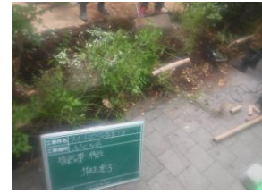
植栽帯防護柵撤去
