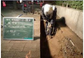
光回線敷設工事
