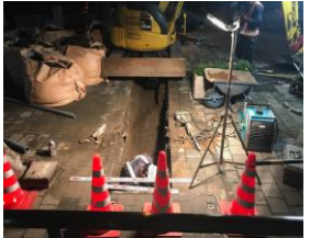
光回線敷設工事
