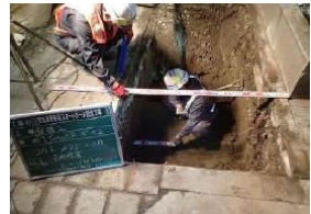
基礎工事（掘削）
