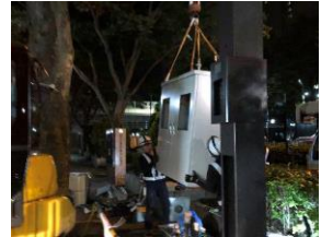
設置工事 (収納箱)
