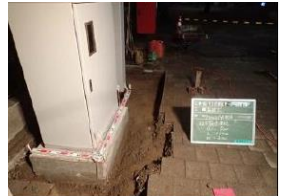
設置工事（収納箱）
