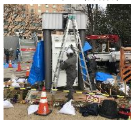
設置工事 (建柱)
