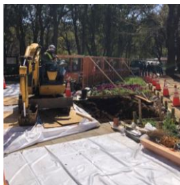
基礎工事 (掘削)
