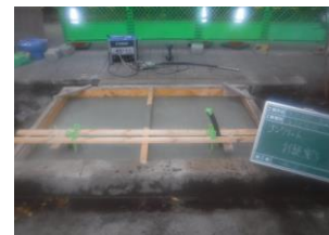
基礎工事 (生コン打設)
