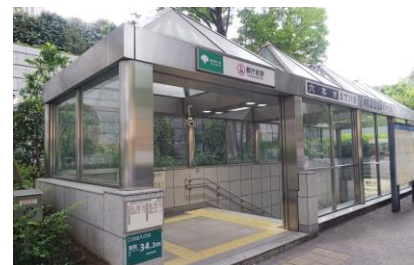
地下鉄出入口
