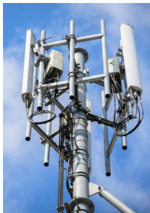
共有アンテナ設置
